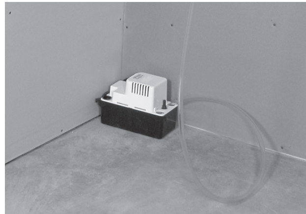
Ensuite, raccorder au renvoi ou à la pompe de condensation si vous n'avez pas accès au drain du plancher.
